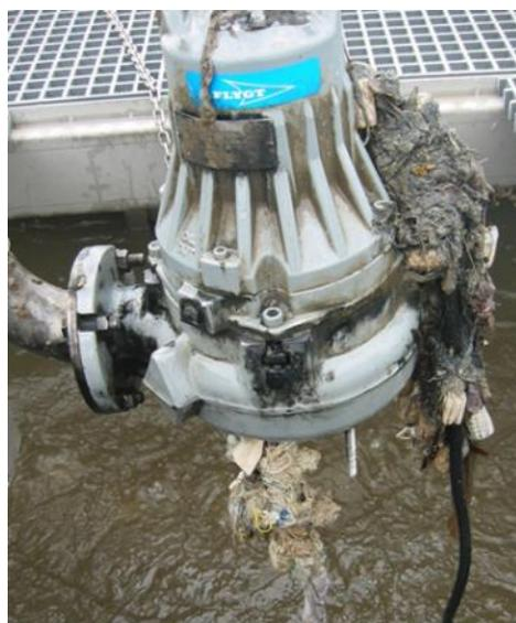
Feuchttücher im Abwasser nicht auflösen, sich um die Pumpen wickeln und diese zerstören. Die Mitarbeiter der Kläranlage haben dadurch einen immer größeren Wartungsaufwand.
